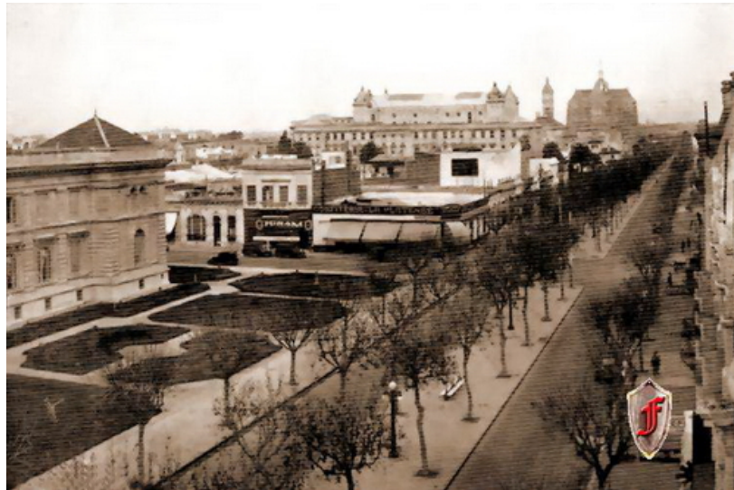
La Avenida 51 hacia 1930. Se nota el papel de referentes urbanos que jugaban los edificios institucionales del Eje en relación con el tejido urbano.
