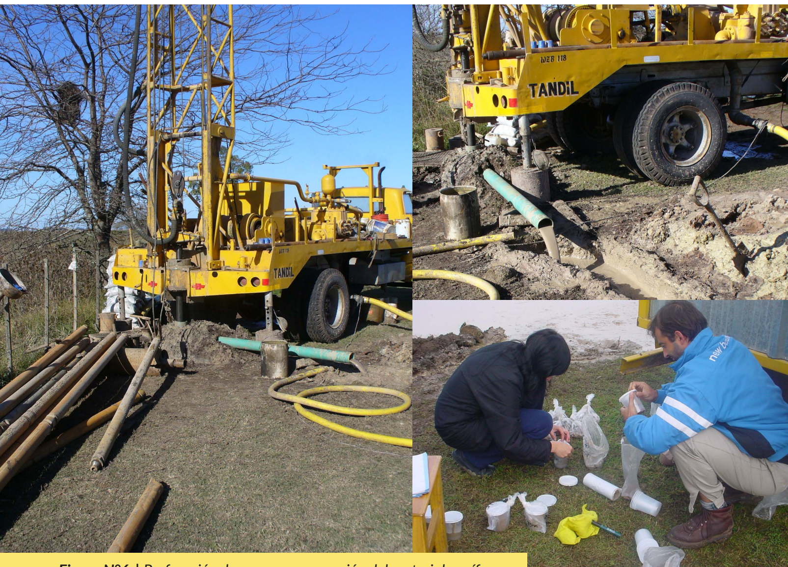
Figura N°6 | Perforación de pozo y recuperación del material acuífero.
