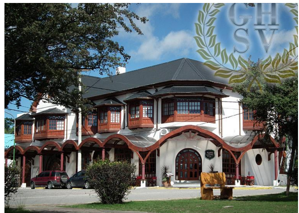
Figura 11 - Remodelación al Primer Hotel
