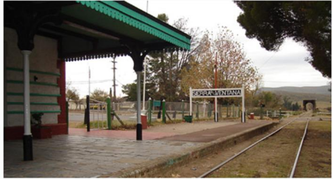
Figura 7 - Estación de Ferrocarril
