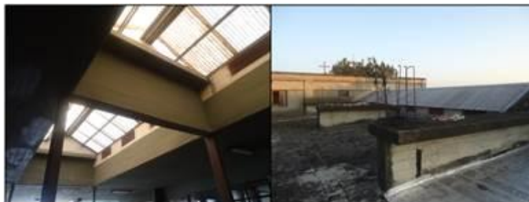
Figura 9: Vista de viga “T” central desde el patio central (izq.) y Vista de viga “T” desde la terraza (der.).
