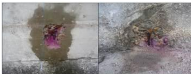
Figura 11: Ensayo y medición de carbonatación con fenolftaleína
