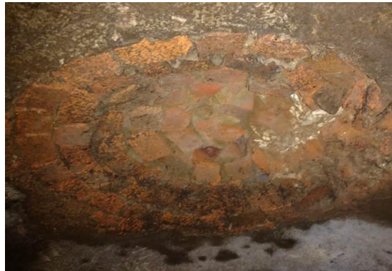
Figura 2: Cúpula de la cisterna
