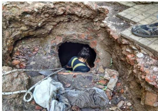
Figura 6: Limpieza de la cisterna
