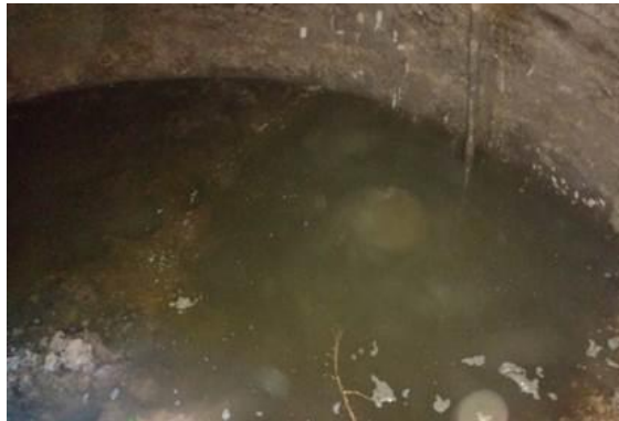
Figura 5: Interior de la cisterna con agua
