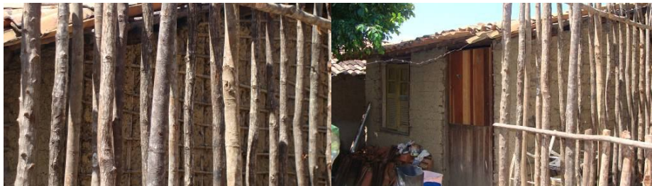
Figuras 14 e 15: Técnica construtiva do tipo Taipa de Mão ou Sopapo; Fonte: Daniella Esposito, 2009
