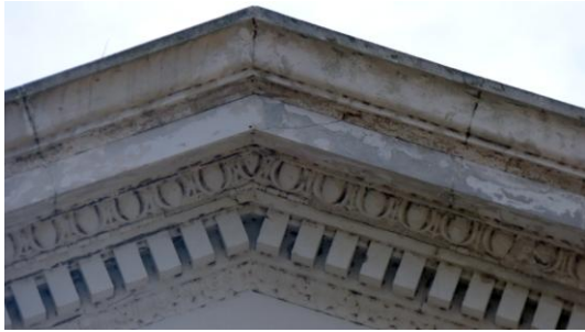
Figura 26: Cumbreira del Tímpano
