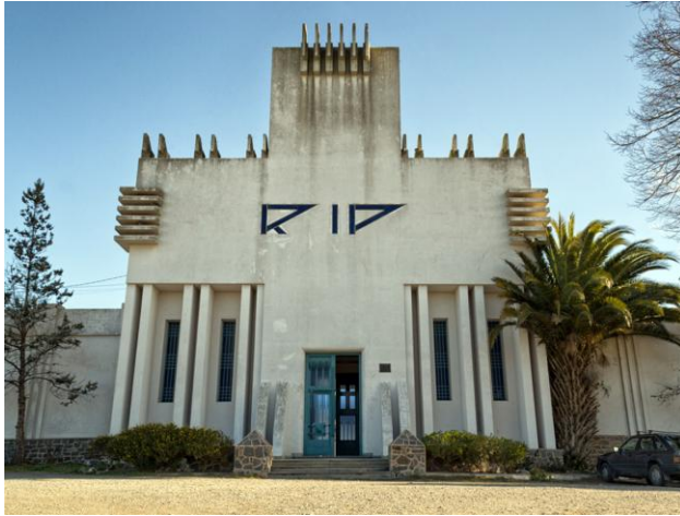
Figura 32: Cementerio de Balcarce
