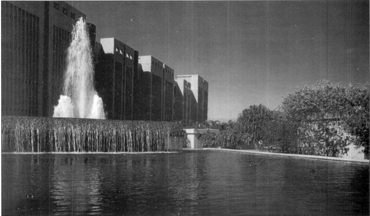
Figura 4. Edificio Sede Corpoven, PDVSA, Venezuela.
