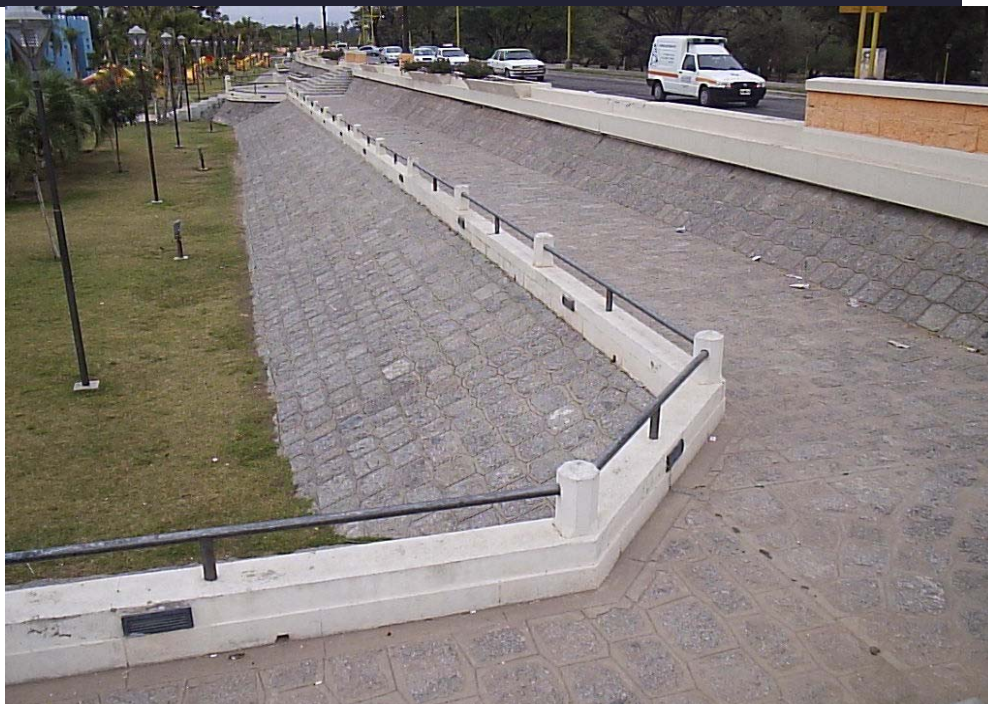
Figura 5 – Revestimiento del talud mojado
