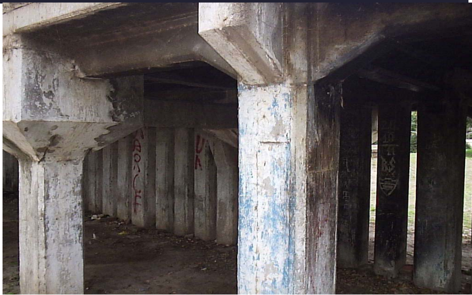
Figura 6 – Estructura tipo de los espigones de hormigón armado
