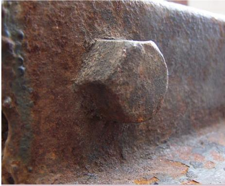
**Fotografía 3: Detalle de un elemento metálico. Se observa la cabeza del bulón empleado para el ensamble de dos piezas metálicas.**
