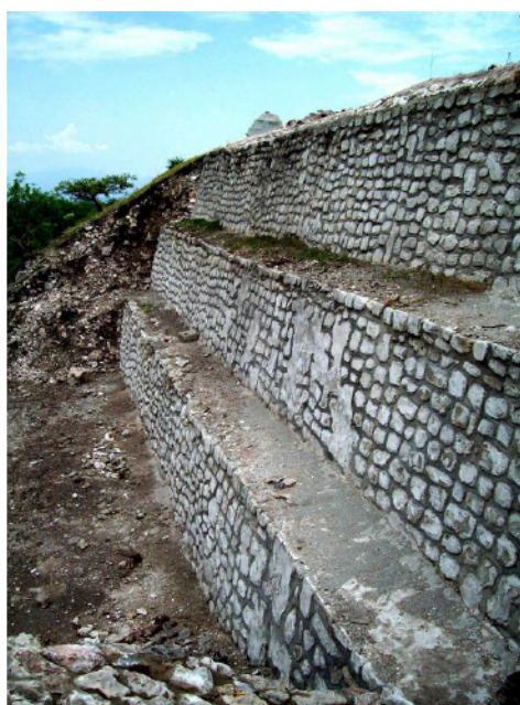
Figura 9: Sistema de muro de contención empleado en Xochicalco. (Foto: J.G.O.H.)
