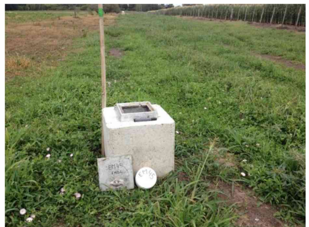
Figura 9. Dado de hormigón de los freatímetros y tapa de fundición.
