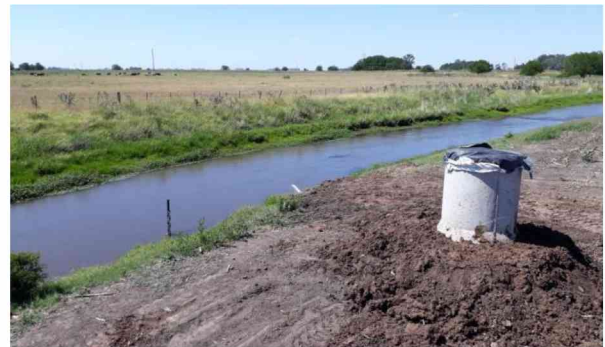
Figura 8a. Caños de hormigón armado de forma vertical donde se encuentra el sensor.
