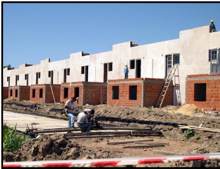
Imagen 1: Conjunto de relevamiento de Berisso
