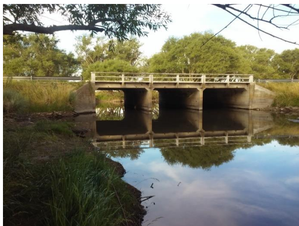
Foto 5-1-Puente Sobre Aº de Los Huesos RP226 desde aguas arriba
