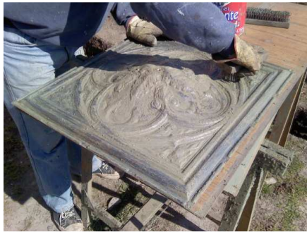
Figura 11 – Retiro manual de pintura
