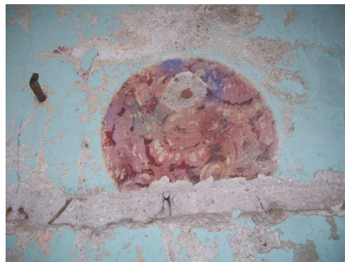
Figura 5 – Resto de pintura mural de la sala
