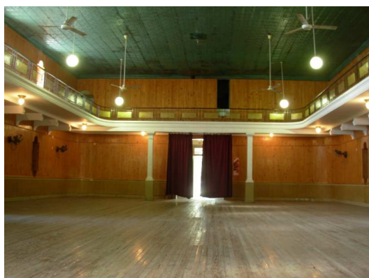
Figura 7 – Estado de la sala previo a la intervención
