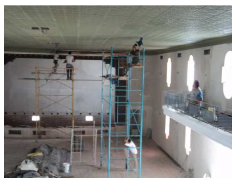
Figura 17 - Montaje de placas
