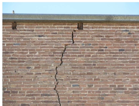
Figura 8 – Detalle de Fachada
