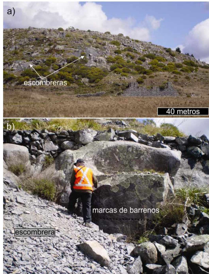
Figura 3.B.2: a) Vista del flanco explotado del cerro, con los sectores de escombreras. Aún permanecen de pie muros construidos con material de la explotación utilizados como contención ante posibles derrumbes. b) En las escombreras pueden verse las perforaciones correspondientes a los barrenos.
