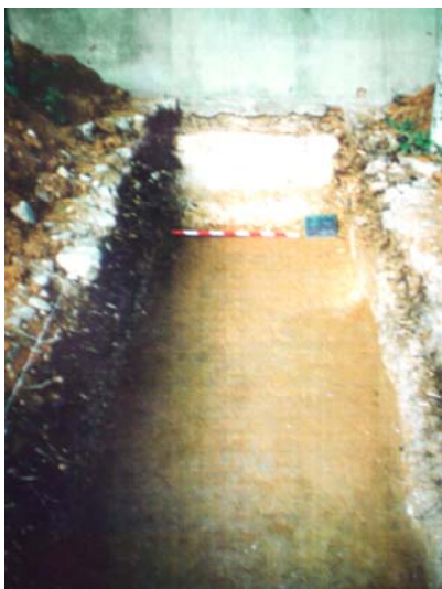
Sondeo 5 Fuente: Archivo del Palacio Arzobispal, aquí podemos ver solado de baldosas cerámicas bizcochadas de 28 X 18 X 3. Fuente: Trinidad Yunquera
