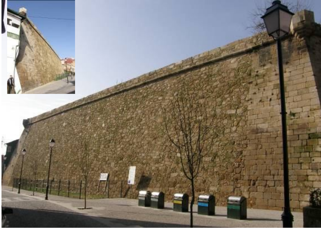
Figura 17. Aspecto final do Baluarte do Cavaleiro da Muralha de Chaves.
