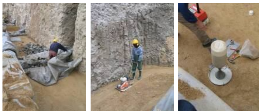
Figura 15. Ligação dos drenos transversais ao dreno longitudinal. Compactação e ensaios no aterro controlado.
