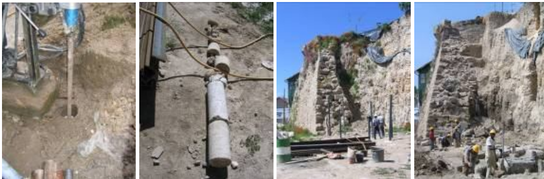
Figura 13. Preparação para a execução de Jet-grouting e arranque da fundação da muralha.
