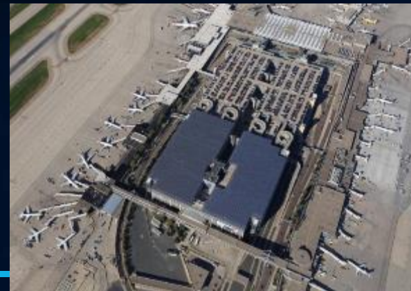
1er Congreso sobre medios de transporte y sus tecnologías asociadas - Septiembre de 2018 - Huelga Auckland International Airport 1.3 MW
