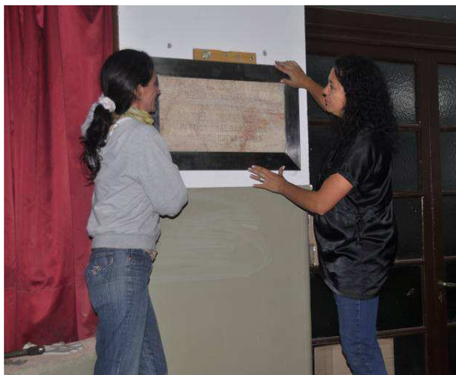
Figura 19. Toma de nivel para la fijación definitiva de la placa.
