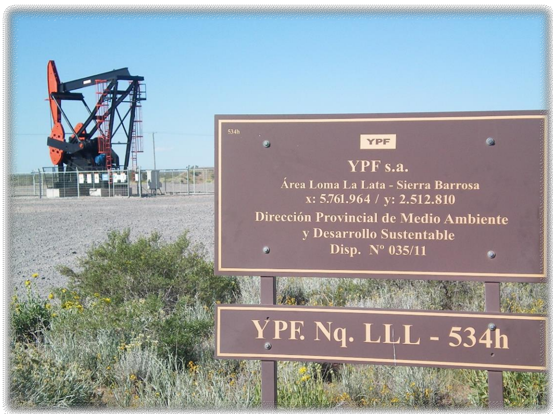
Imagen 1. Pozo petrolero en el yacimiento Loma La Lata
