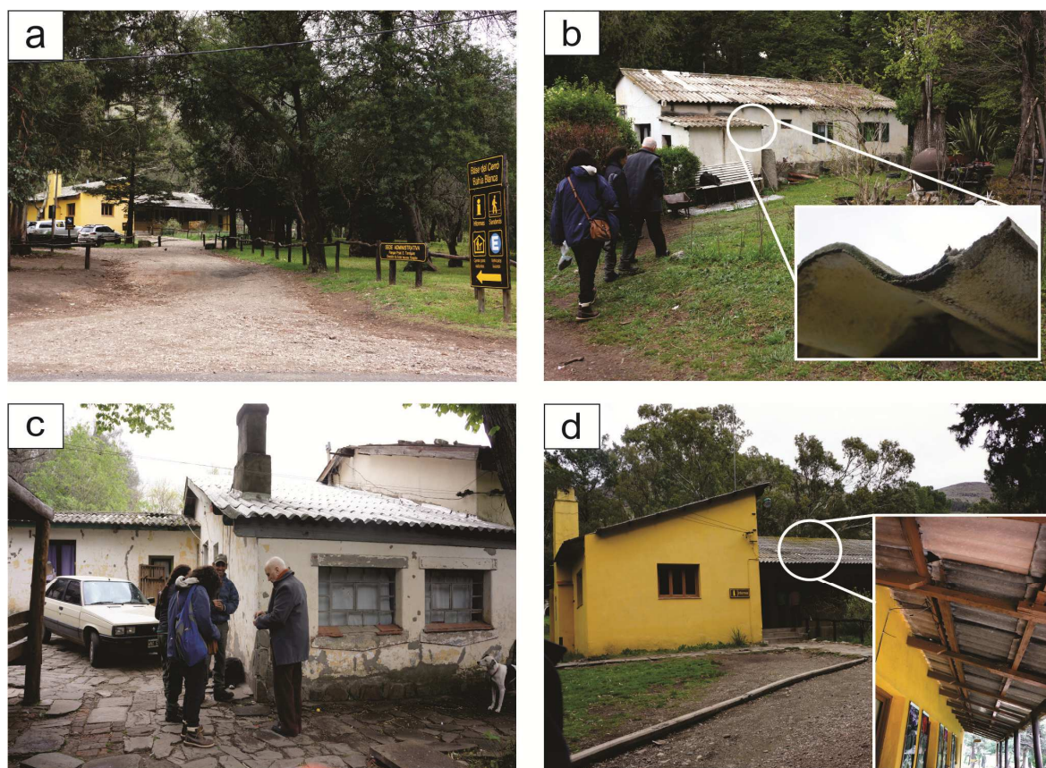
Figura 2: a: acceso al área relevada. b: casa del personal del parque y detalle de las chapas. c: otra casa relevada d: recepción y administración del parque y detalle de la rotura de los techos.
