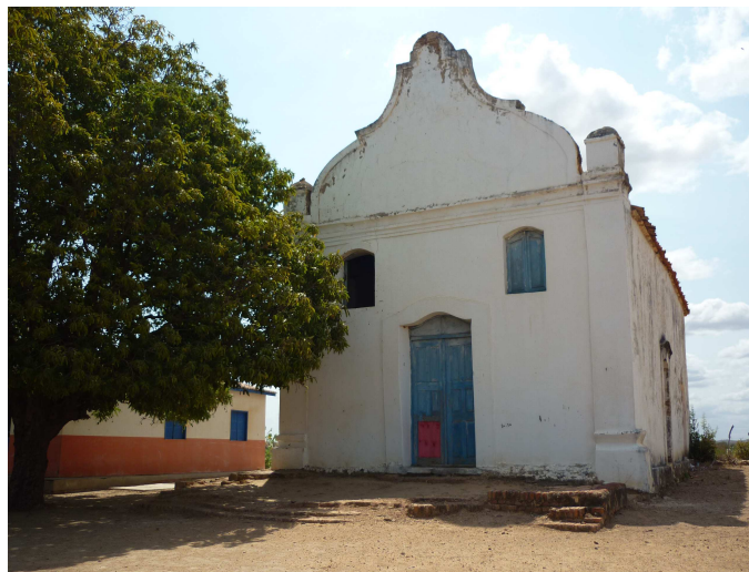
Figura 1 – Fachada principal da Capela de Santana do Miradouro
