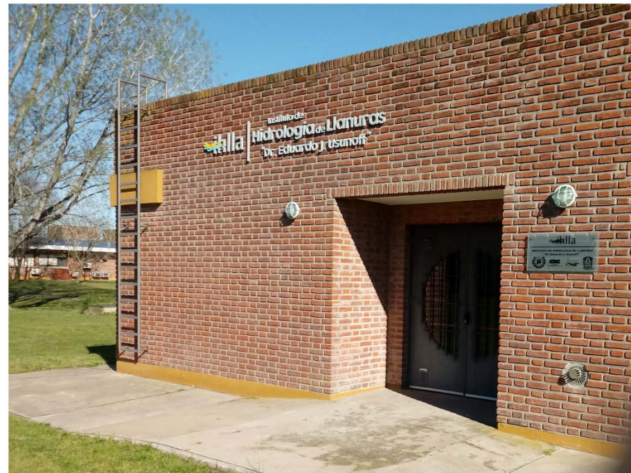
Frente del Instituto de Hidrología de Llanuras
