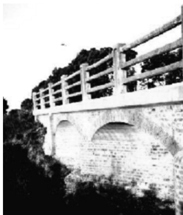
Figura 6: Puente sobre Ruta 205. Partido de Lobos.
