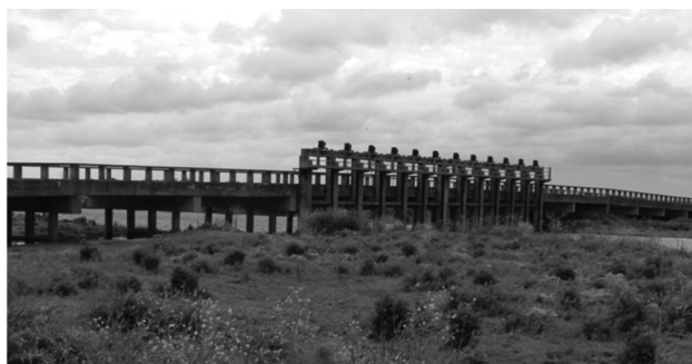
Figura 9: Puente esclusa sobre Canal 1 (Tordillo)
