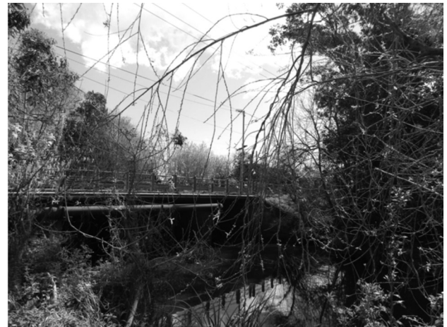
Figura 1: Puente sobre el arroyo Doña Flora.
