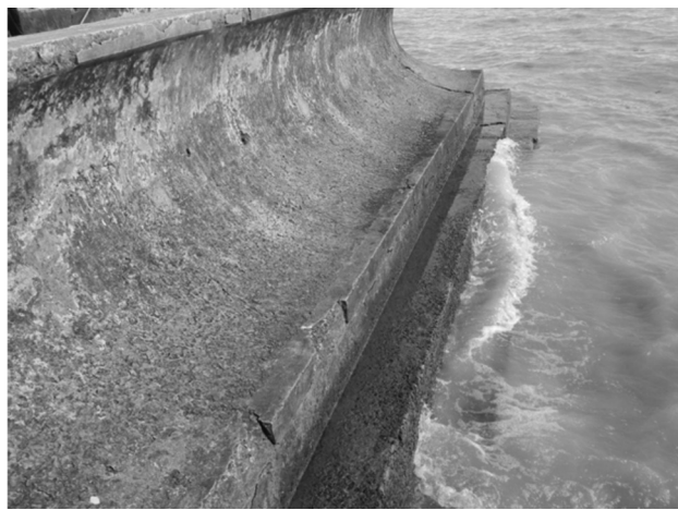
Figura 7: Muralla de defensa sobre la Av. Costanera.
