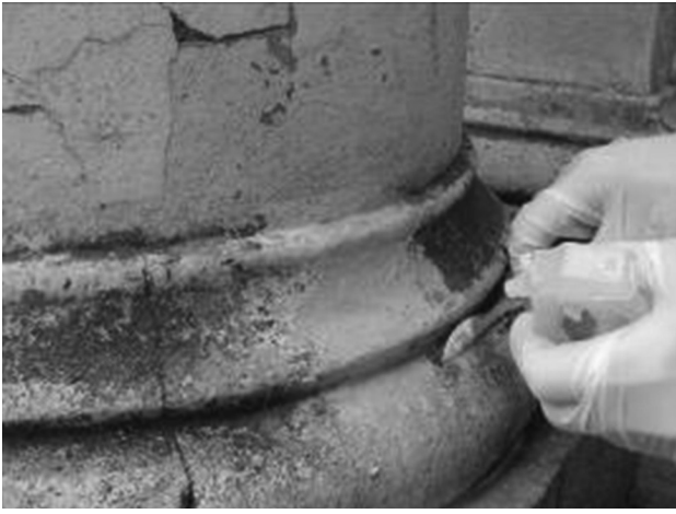
Figuras 43 y 44: Limpieza mecánica en superficie húmeda y enjuague.
