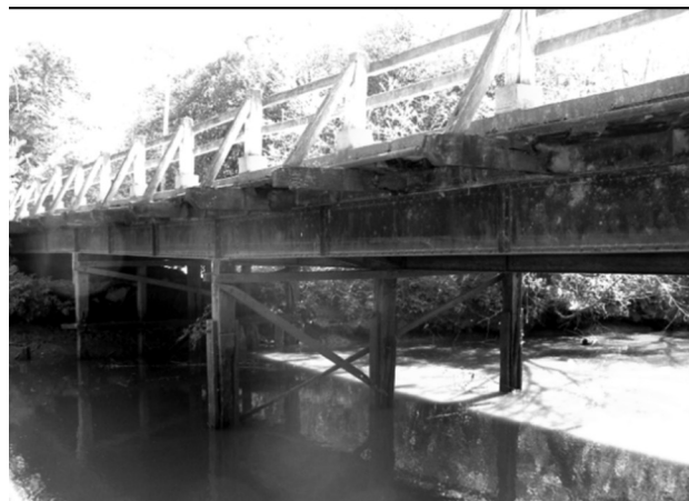
Figura 3: Vista del puente
