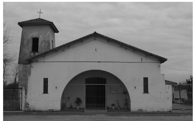
Figura 5: Vista de la Iglesia San José Obrero.
