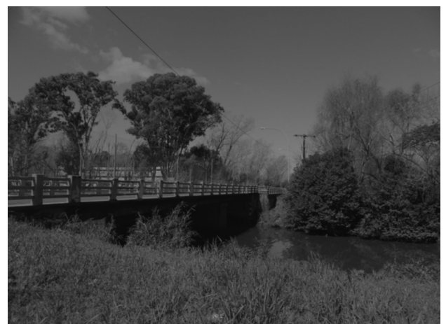
Figura 3: Puente sobre el canal del Arroyo Rodríguez
