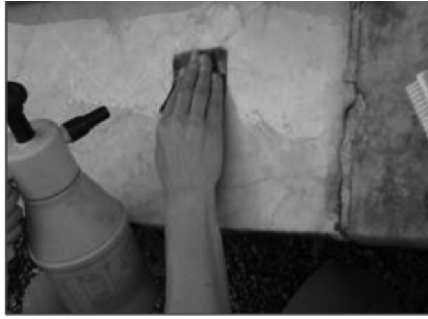
Figuras 46 y 47: Suavizado de la superficie mediante lijas de grano 1000-2000.
