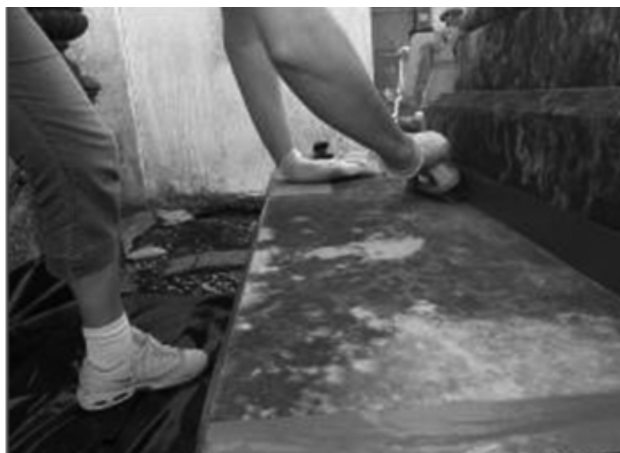
Figura 37: Cepillado a seco de la superficie.
