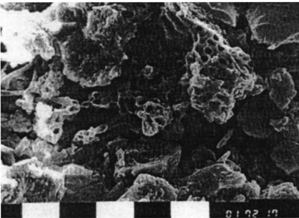
Figura 3: X. austroctrina . Detalle del hormigón atacado.
