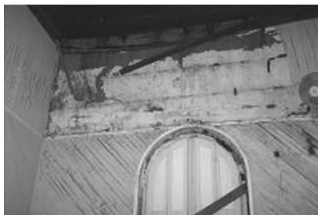
Figura 48: Esquina colapsada.
