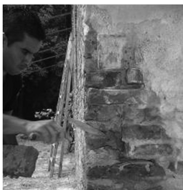
Figura 31: Reposición de ladrillos.
