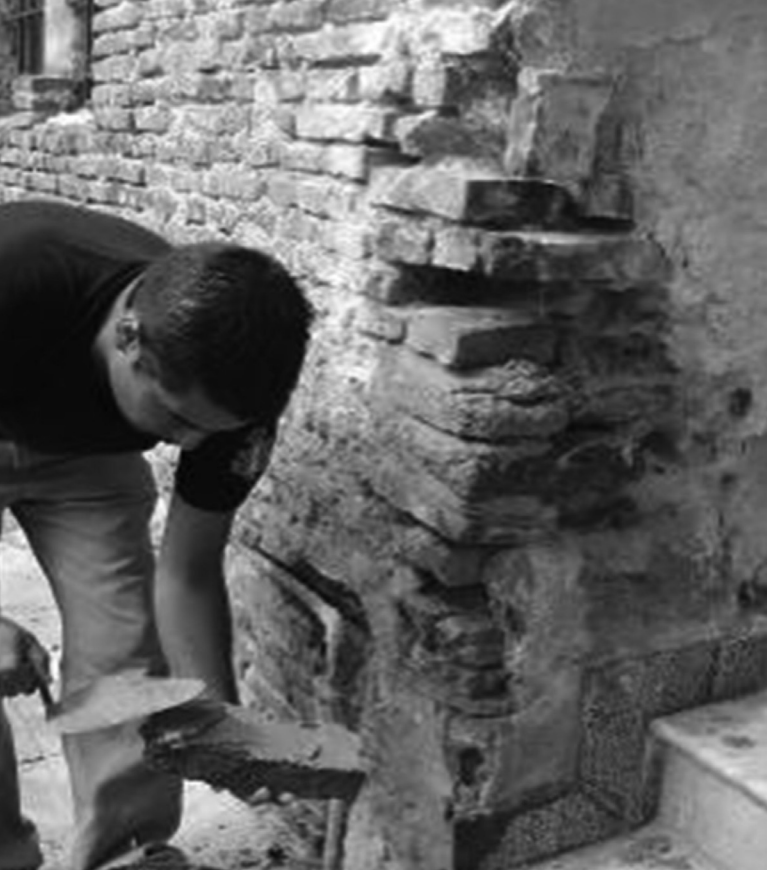
Figura 32: Reposición de ladrillos.
