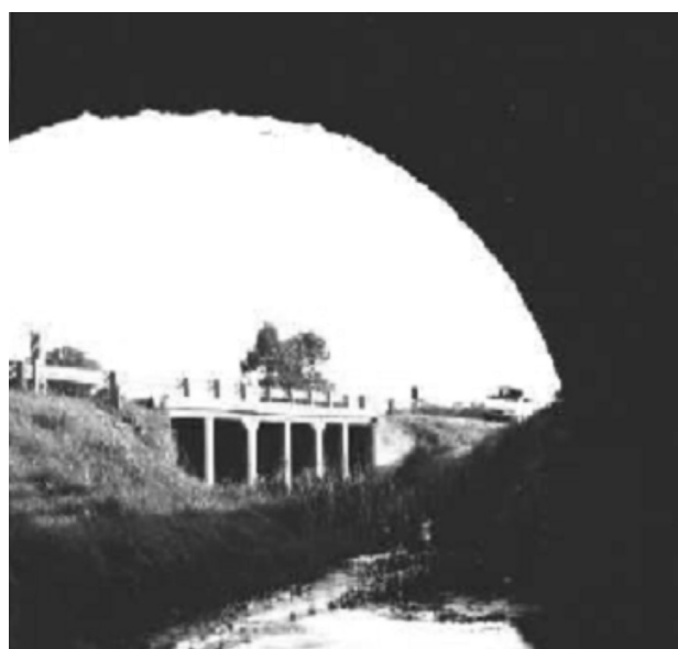
Figura 5: Puente sobre Ruta 205. Partido de Lobos.
