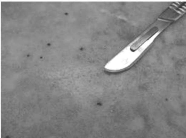
Figura 44: Superficie rugosa del mármol con oquedades.
