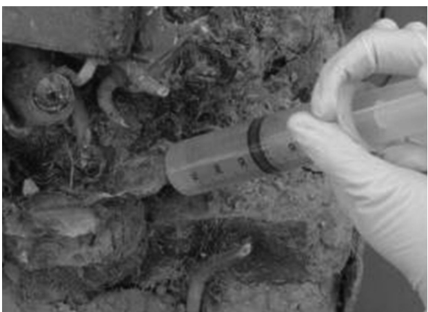
Figuras 22 y 23: Inyección del herbicida y taponamiento.
