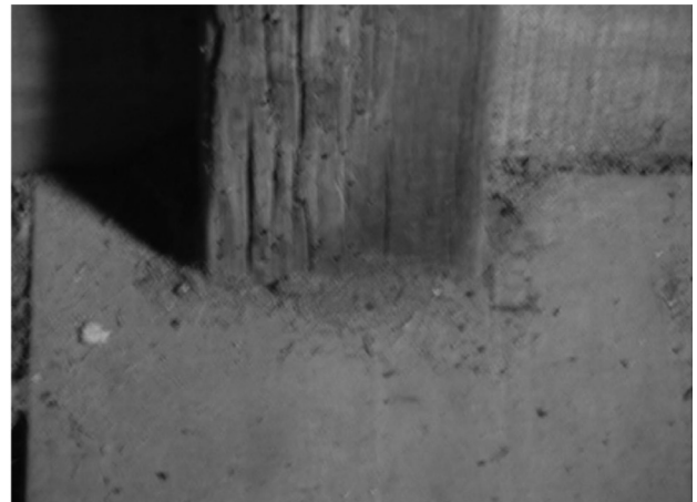
Figura 26: Madera afectada por carcoma, en el taller del poeta-pintor A. Bustillo, en Berazategui.
