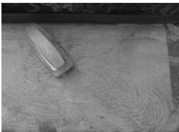
Figura 38: Aplicación de tensoactivo.
