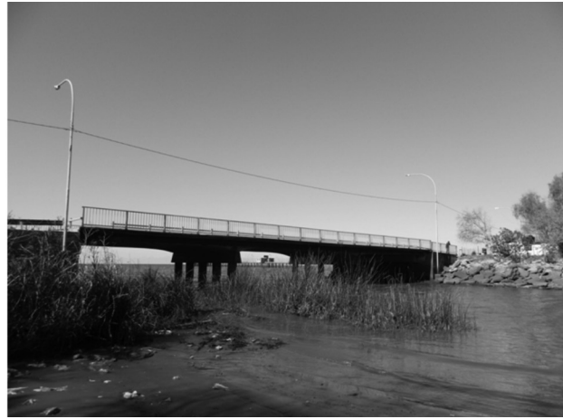
Figura 5: Puente sobre canal del Arroyo Villa Elisa (Boca Cerrada).
