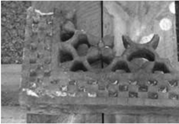
Figura 27: Rejilla de roca calcárea luego del crioarenado a 3.5 bar. La limpieza no resulta satisfactoria.
