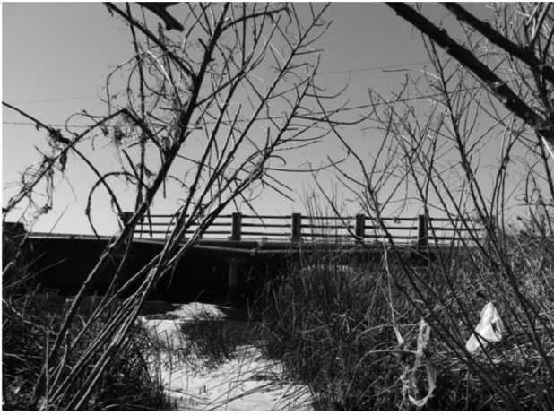
Figura 4: Puente sobre el Arroyo Miguelín
