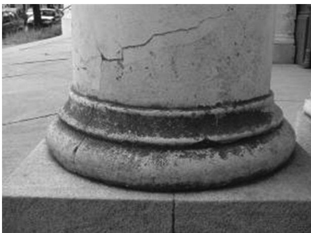
Figura 40: Base de la columna.
