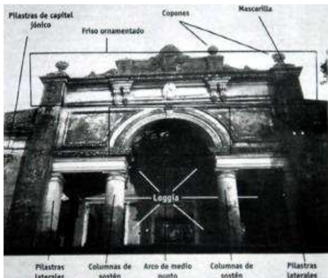
Figura 4: Detalle de ornamentaciones de fachada.
