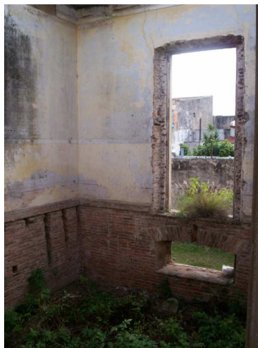
Figura 7: Interior de una de las habitaciones.
