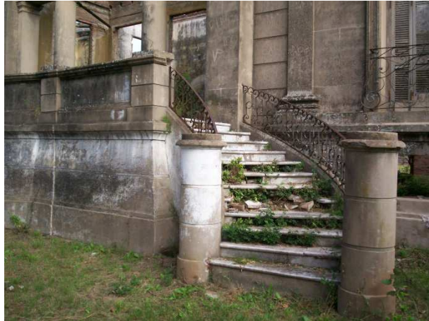
Figura 3: Vista de una de las escaleras de ingreso
