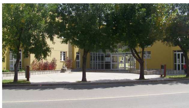
Vista frontal del ingreso al ISFT n° 194
