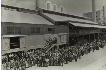
Fig. 1. Planta de la Cía. Argentina de Cemento Portland
