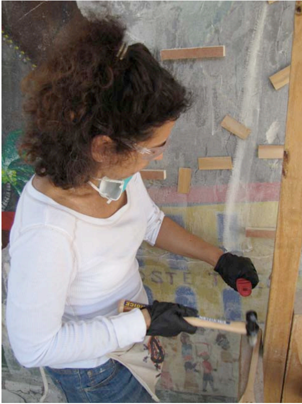
Viviana Dominguez cincelando las grietas para separar el fragmento a retirar
