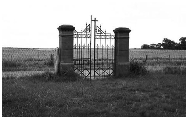
Detalle del portal de ingreso al predio. Se observa a los laterales el alambrado como parte del cerramiento perimetral.
