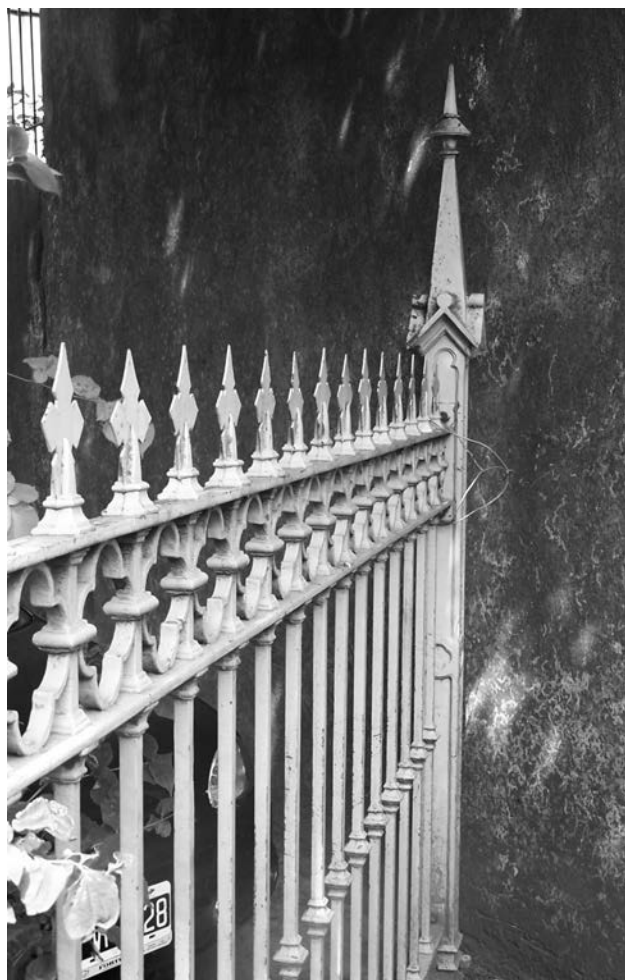
Vista de un tramo de la reja original la cual posee columnas con un diseño similar a los ornamentos del atrio y a los del exterior del edificio.
