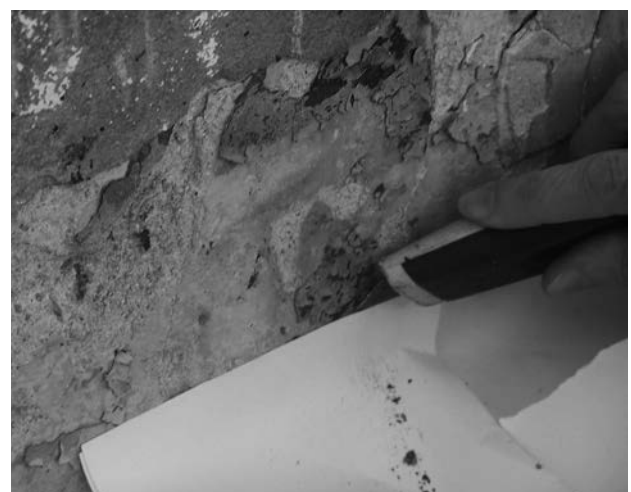
Extracción de muestras de pintura.
