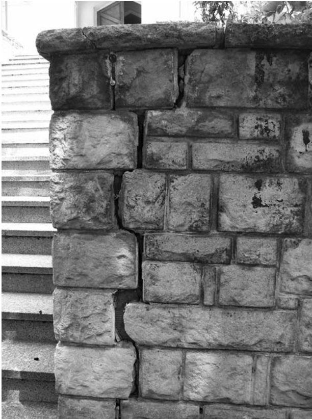
Detalle del muro exterior.
