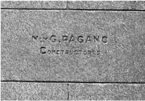
Detalle de muro externo. Se observa grabado sobre el revoque el nombre de la empresa constructora.
