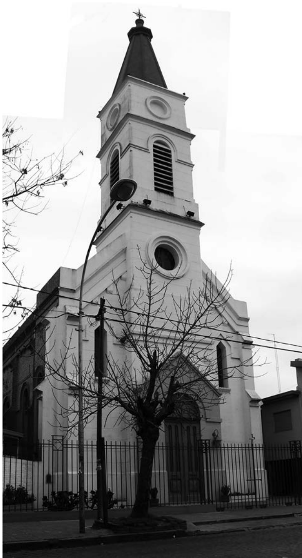
Vista de la fachada de la parroquia María Auxiliadora. Berisso.
