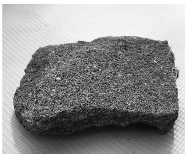
Revoque extraído a una altura de 200 mm (20).
