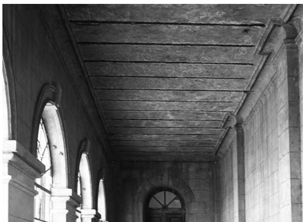
Vista de la cubierta de la galería lateral. Se observa el sistema de bovedillas ejecutado con perfiles metálicos.
