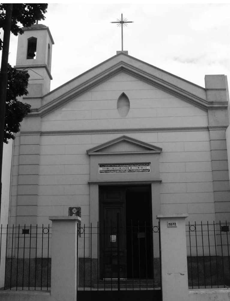
Detalle de la fachada de la Catedral San Pedro. La Plata.
