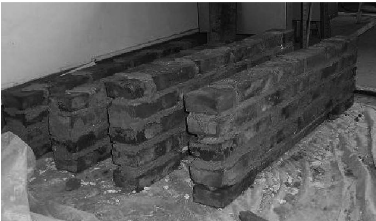
Dinteles de mampostería ejecutados y colocados en las experiencias de refuerzo.
