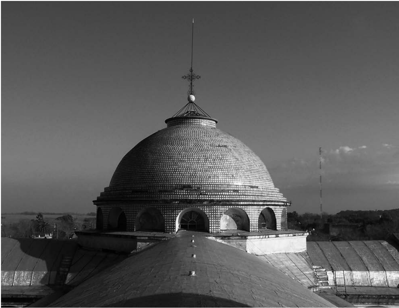
Detalle de la cúpula revestida en mayólicas originales de Pas de Calais.
