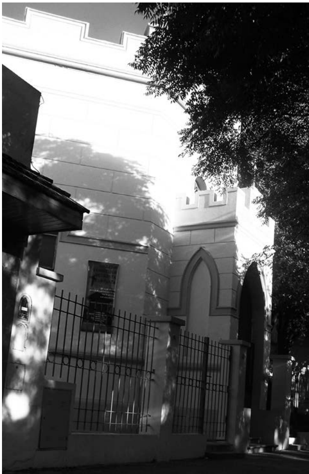
Vista de la fachada de la Iglesia Evangélica Metodista Episcopal. La Plata
