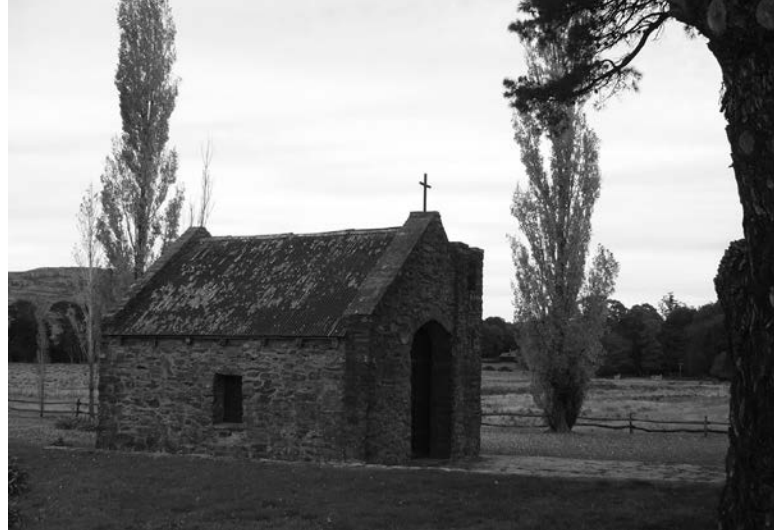
Capilla en piedra. Localidad de Pablo Acosta. Partido de Azul.
