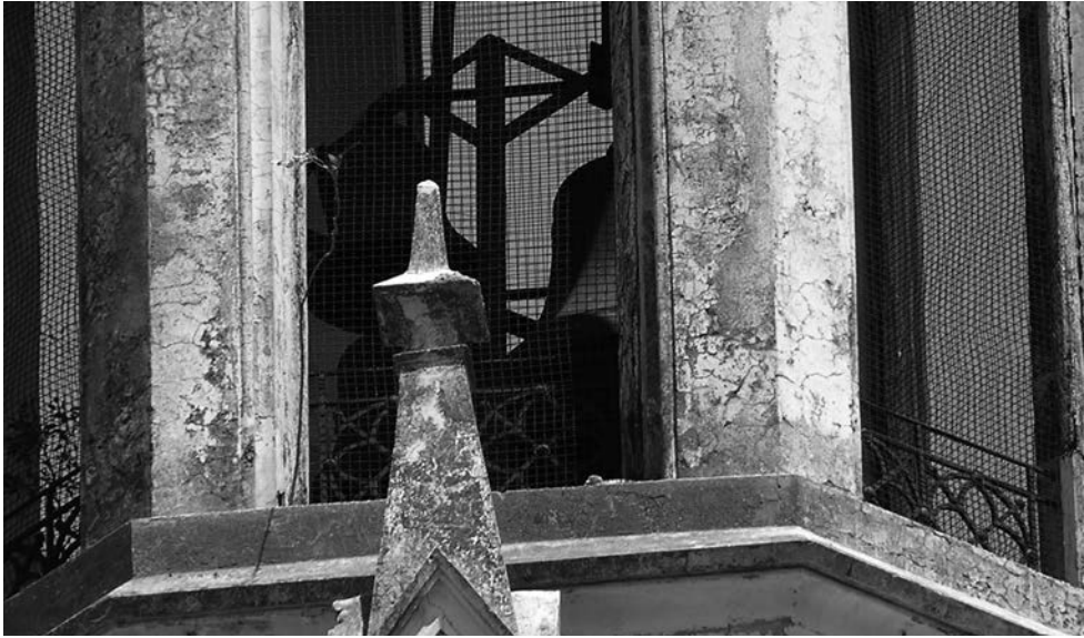
Vista exterior del campanario. Se observa la estructura conformada por pilares de mampostería.
