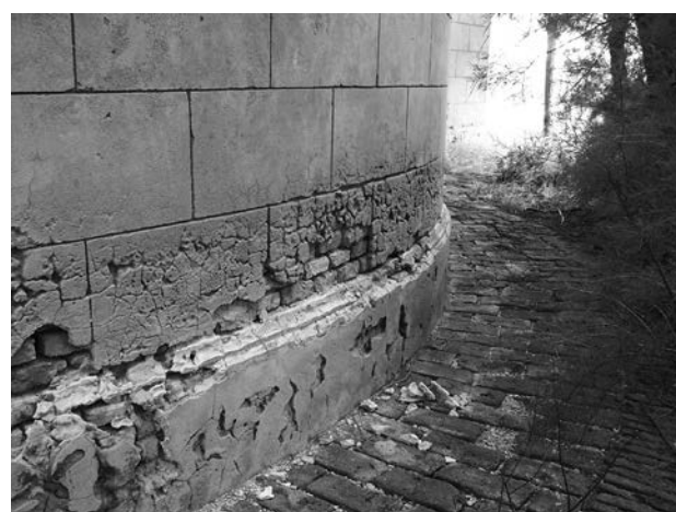
Detalle de la vereda perimetral. Se observan los ladrillos cerámicos comunes que conforman la vereda.
