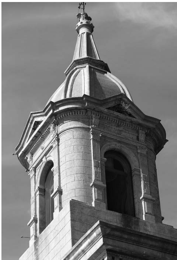
Detalle de la torre del campanario. Se observa el recubrimiento de la cubierta con piezas cerámicas.
