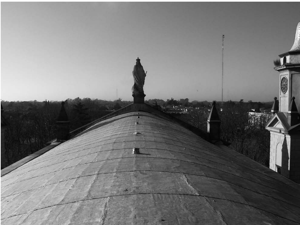
Vista de parte de la cubierta de la bóveda de la Nave Principal protegida con membrana asfáltica.
