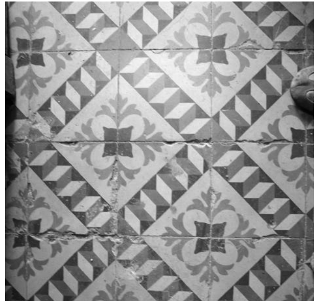
Detalle del solado de una de las galerías laterales.
