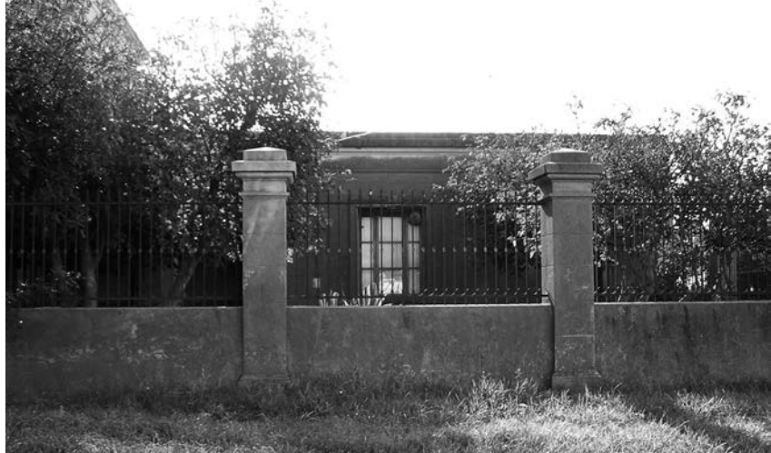
Detalle del cerramiento perimetral. Se observan los pilares y las rejas metálicas.
