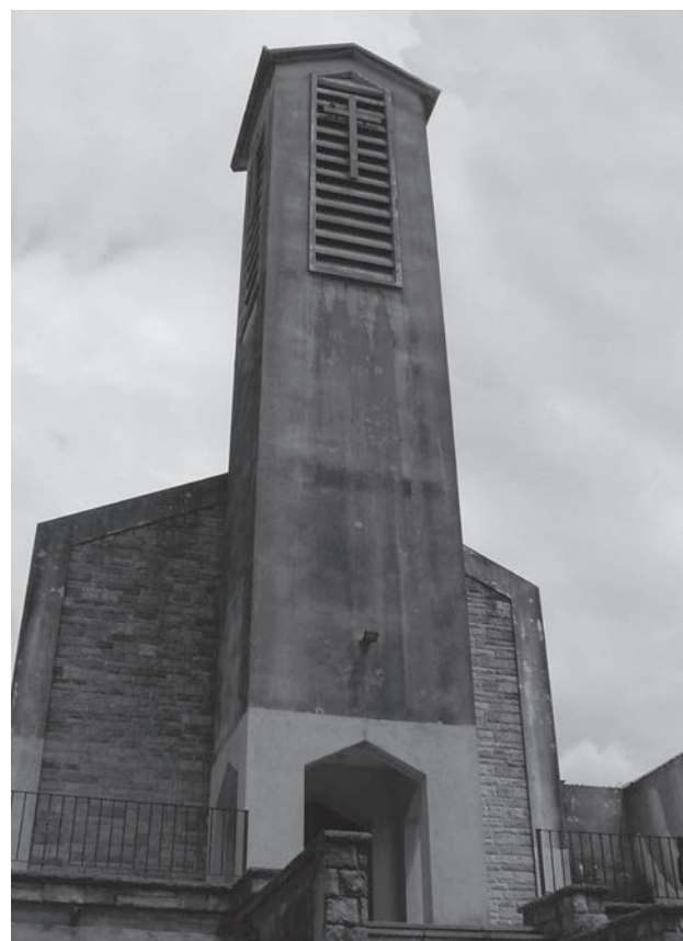
Vista de la fachada de la Iglesia Evangélica Luterana Unida San Timoteo. La Plata.
