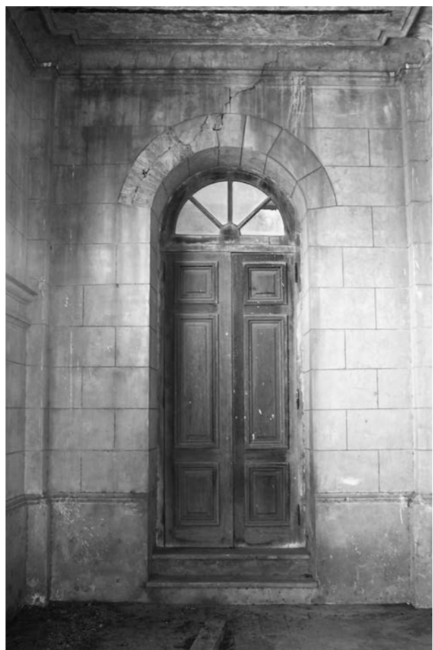
Vista de una abertura de acceso en la galería lateral ejecutada con madera.
