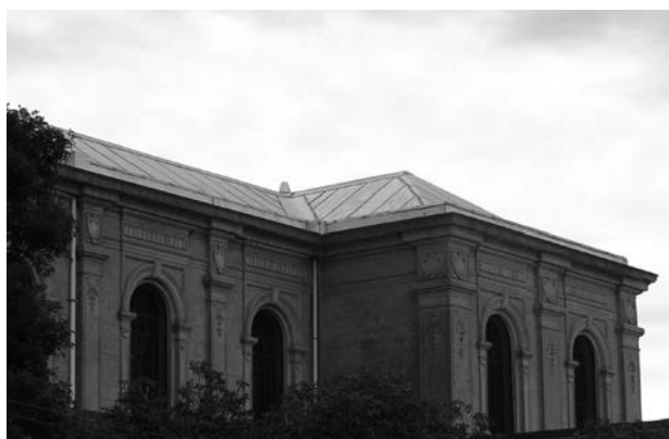
Detalle de la cubierta de la iglesia. Se observa la membrana asfáltica.
