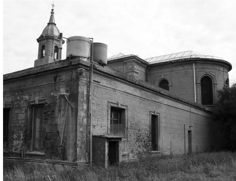
Vista posterior de la construcción. Se observan los tanques reservorios de agua colocados con posterioridad.
