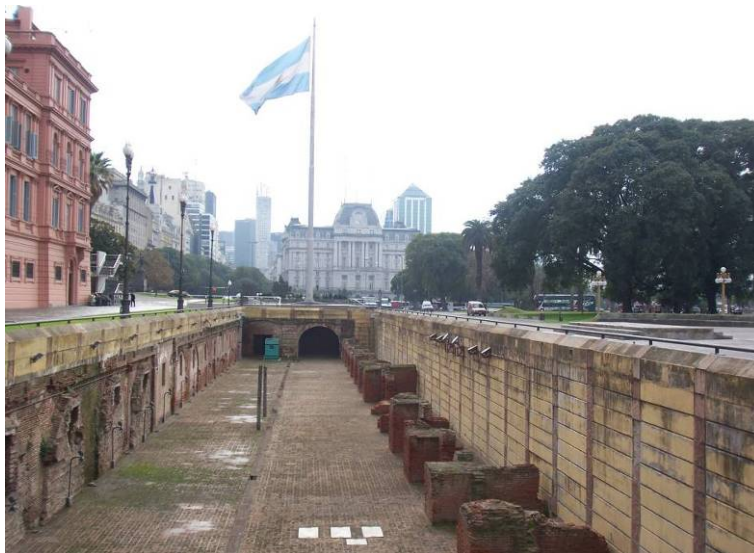
Figura 3. Patio de Maniobras, Aduana de Taylor, 2008. Fuente: F. García Zúñiga.
