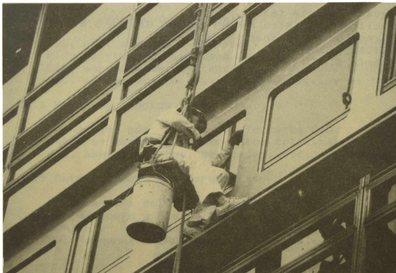
EDIFICIO DE SOMISA EN LA CAPITAL FEDERAL.- CIDEPINT preparó las especificaciones para el pintado y realizó la inspección de la obra.
