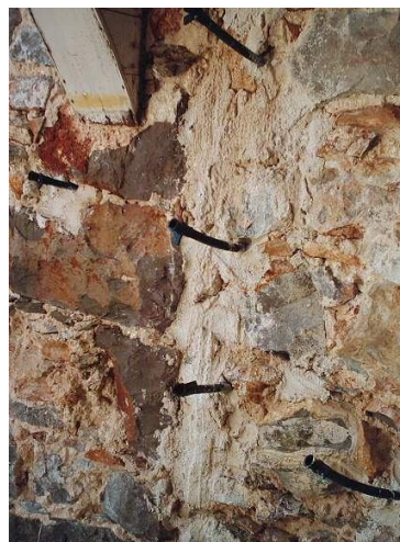
Foto 25. Bocas de injeção
