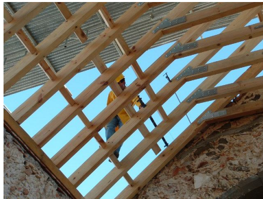
Foto 42. Madeiramento nave principal
