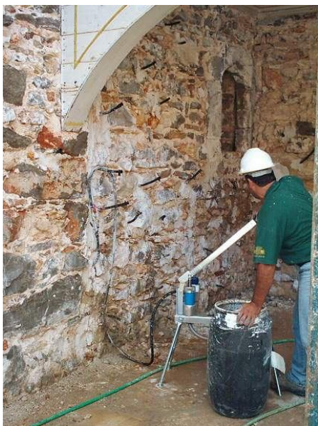
Foto 26. Injecção de Caldas
