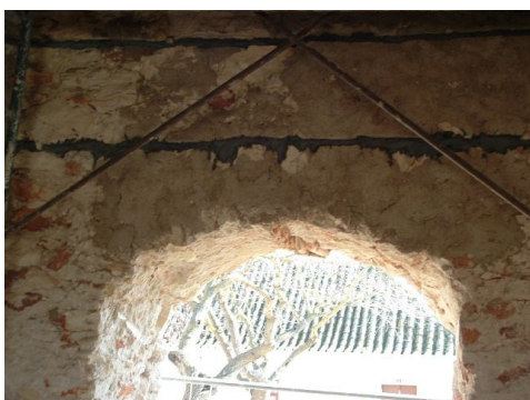
Foto 35. Pregagem interior de verga
