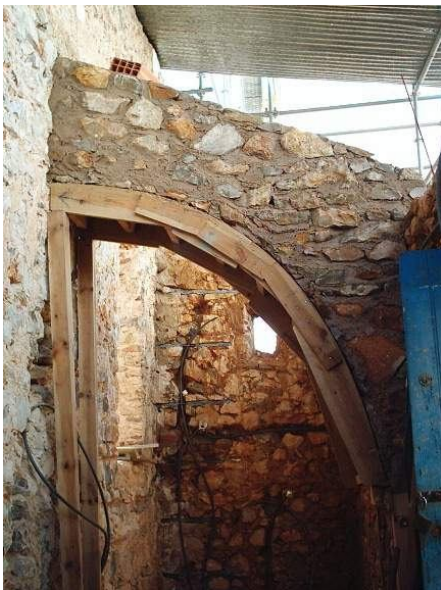
Foto 39. Reconstrução de arco com cimbre
