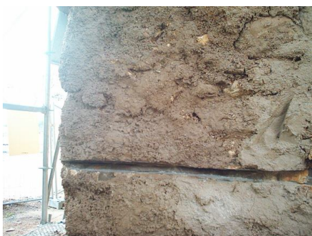
Foto 33. Roço para pregagem
