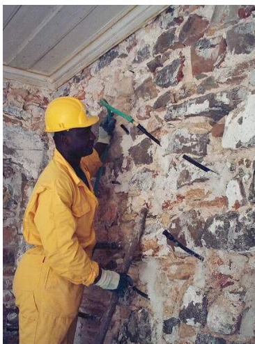
Foto 24. Bocas de injeção
