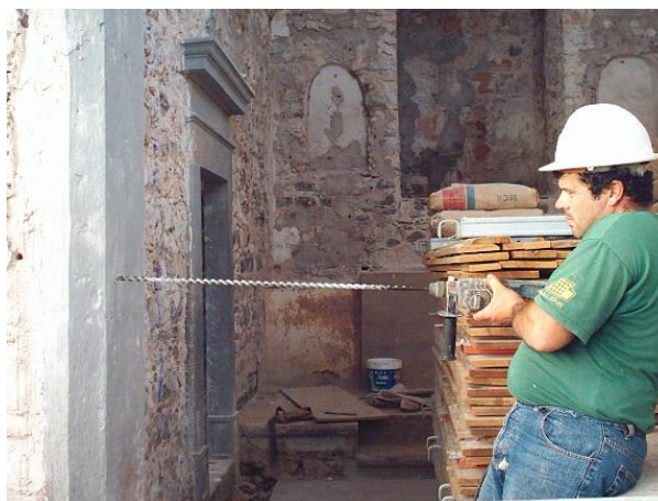
Foto 30. Furacão para pregagens
