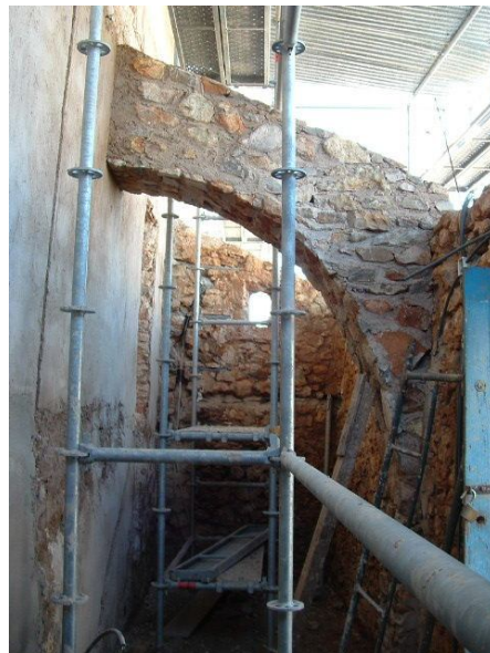
Foto 40. Arco de pedra reconstruído.
