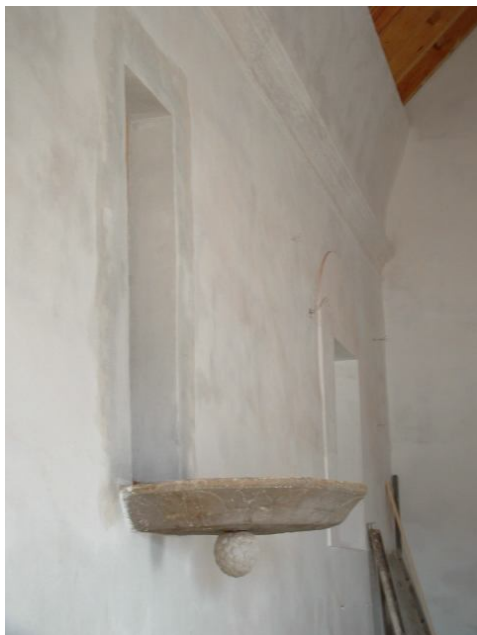
Foto 84. Caição Paredes interiores
