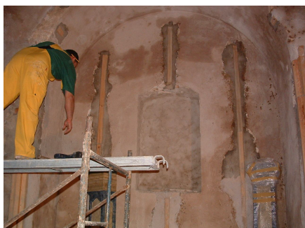
Foto 74. Colocação de tacos para fixação
