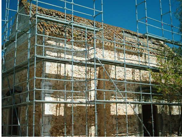
Foto 22. Remoção revestimento paredes exteriores
