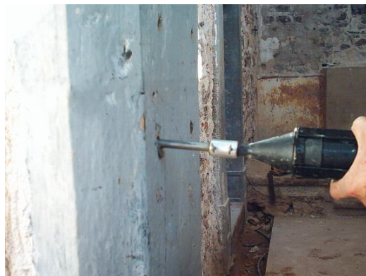
Foto 32. Injecção de pregagem
