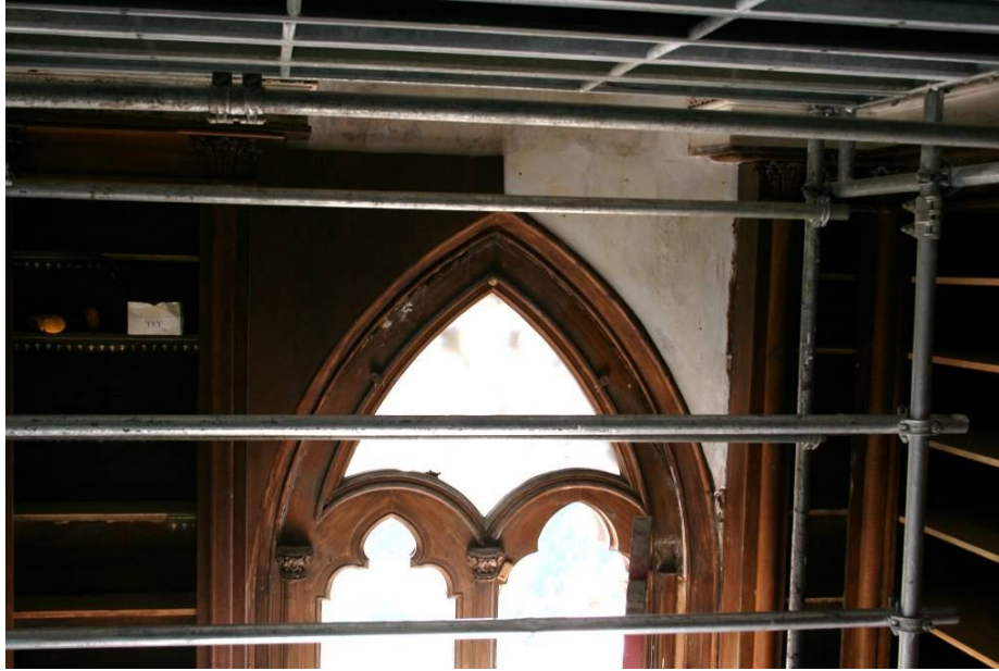
Fotografia 19. Reconstituição da guarnição de vãos e estante anterior reparada.
