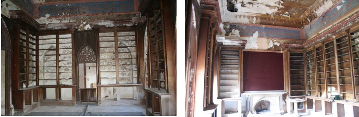
Fotografia 2. a) Parede Sul b) Parede Norte, antes da intervenção
