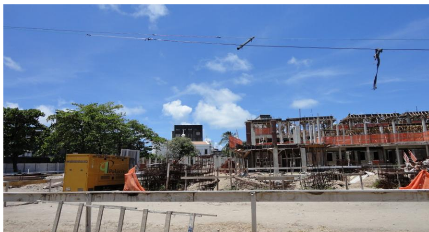
Construção da Primeira Quadra do Habitacional do Pilar
