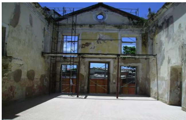
Interior da nave da igreja antes do início das obras, após a limpeza.
