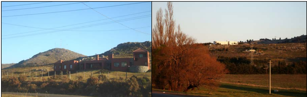
Foto 3. Edificación y cableado visto desde la calle Linstow y Las Hortensias
