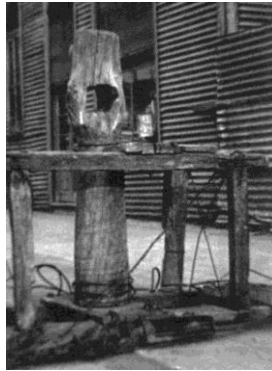
Figura 13 - Elementos y criques utilizados por el "Canario" para trasladar las viviendas.
