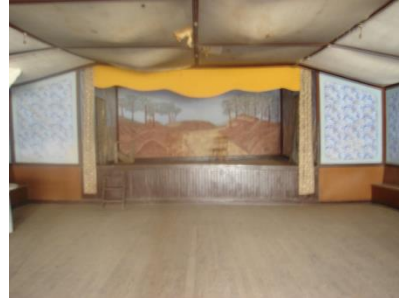
Figura 20 - Interior del teatro. Se puede verificar el uso de la tela para el revestimiento interior y el cielorraso, así como también el solado de madera.
