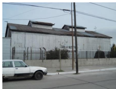
Figura 18 - Vista lateral de la capilla.
