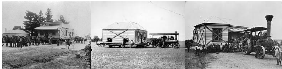
Figura 14 - En estas fotografías se puede observar la cotidianeidad de esta técnica en otros países, en este caso Australia. El traslado se hacía recurriendo a medios mecánicos o por tracción a sangre.
