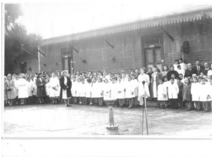
Figura 15 - Patio de la escuela.
