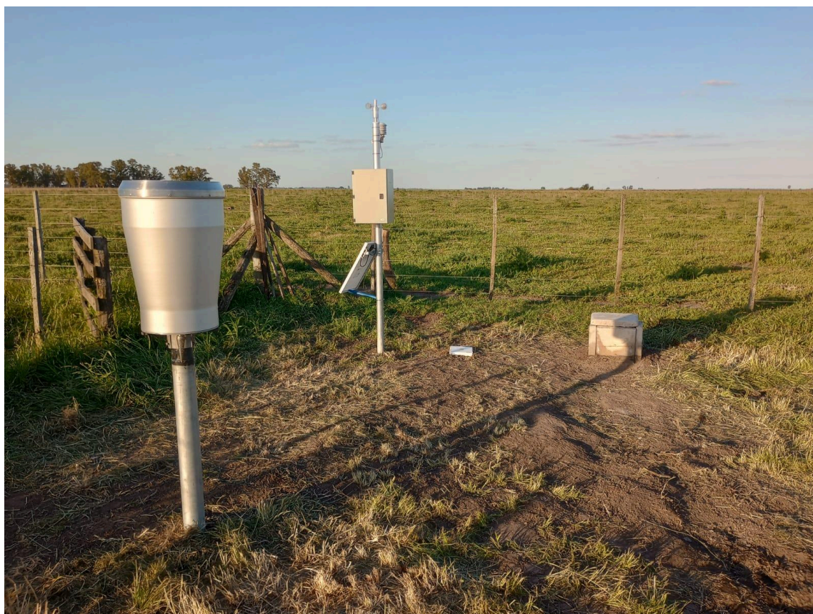
Figura 6: Instalación de estación freatimétrica del día 30/10/2025.
