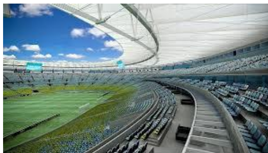
Figura 7 – Vista interna do Maracanã, com a nova cobertura.
