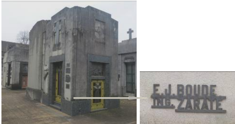
Figura 6: Bóveda Galli, 1941. Zona O, lote 62
