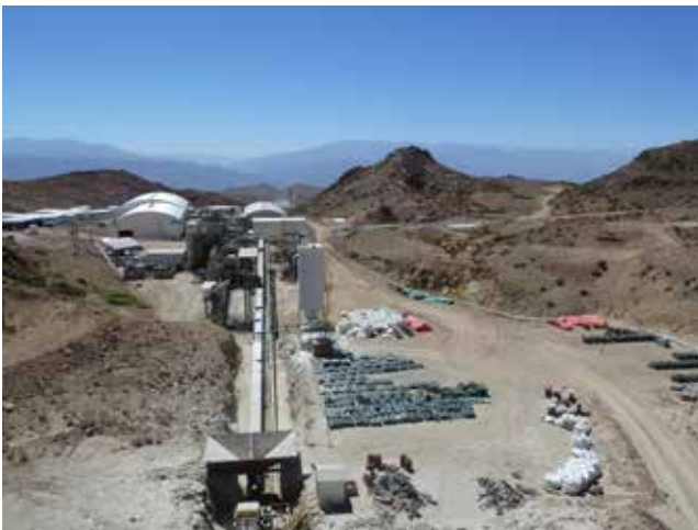
Imagen 6. Instalaciones en la mina Casposo
