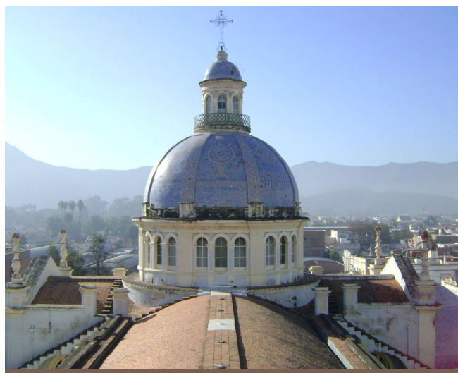
Figura 8. Vista de la cúpula desde la bóveda del techo de la iglesia
