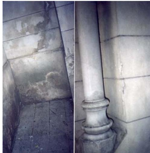
Foto 4: Izq. problemas de humedad ascendente, fisuras; der.: fisuras evidentes. Evidentes reparaciones anteriores en ambos casos por personal poco idóneo.
