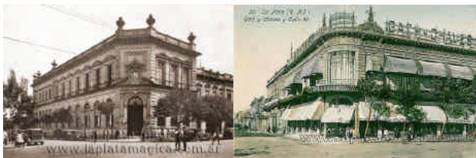
Sede del Banco de Italia (Av. 7 y 48) y Tiendas Gath y Cháves (Av. 7 y 50)
