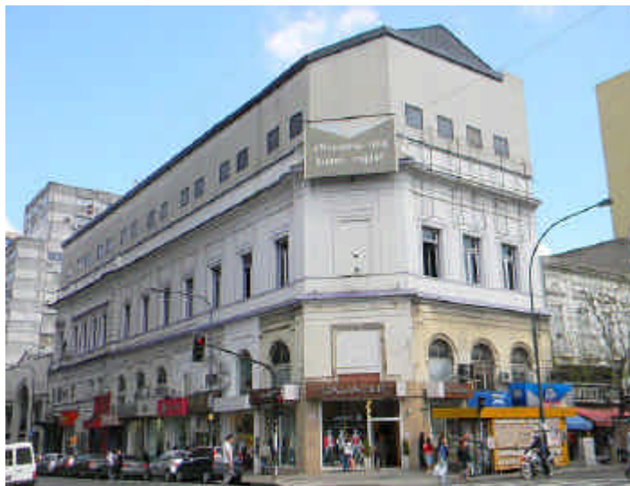
Intervención de modificación y ampliación del ex Banco de Italia y Río de la Plata (Av. 7 y 48) que no respetó los rasgos y valores del inmueble.
