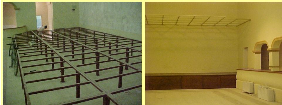
Fotografía 25 y 26: Estructura metálica de escenario y vista del escenario revestido en madera
