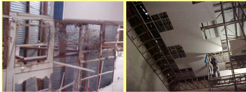
Fotografía N° 16 y 17: Desmonte y ejecución de cielorraso en durlock.
