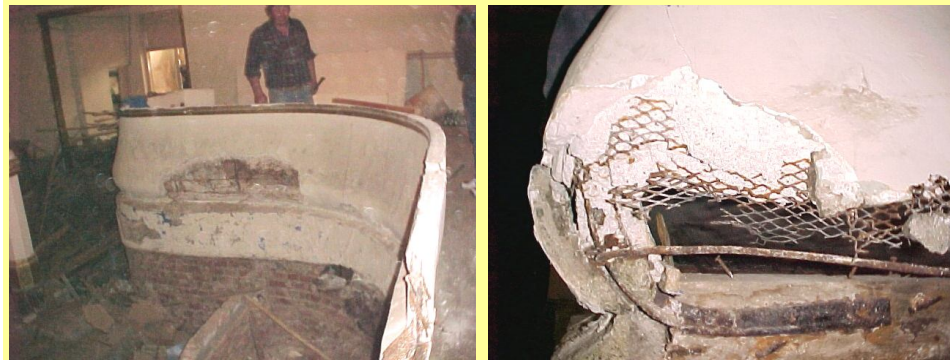
Fotografía N° 3.y 4: tareas de relevamiento en palcos y detalles constructivos
