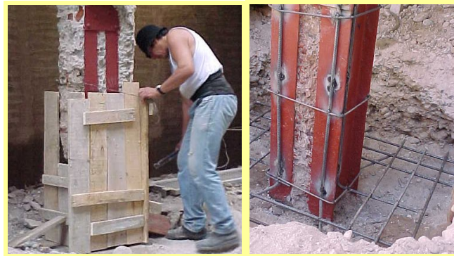
Fotografías N° 13 y 14: Reparación de columnas
