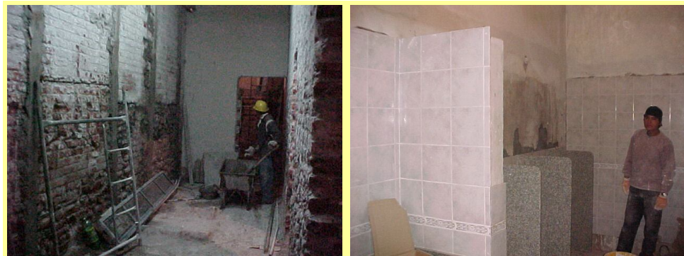
Fotografía N° 20 y 21: Tareas de demolición y restauración en baños.
