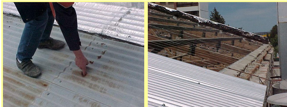
Fotografía N° 18 y 19: Relevamiento de cubierta y colocación de chapas nuevas.
