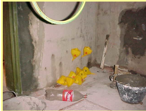
Fotografía N° 10: Inyección del producto químico para impermeabilización de paredes
