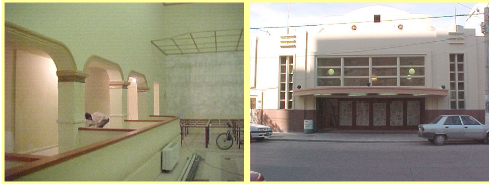
Fotografía N° 30 y 31: Tareas de pintura en el interior y fachada del edificio
