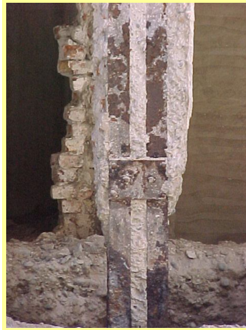
Fotografía N° 12: Detalle constructivo de columnas.
