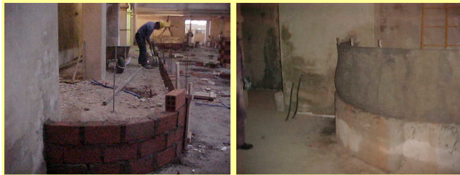
Fotografías N° 5 y 6: ejecución de paredes y revoque en palcos.
