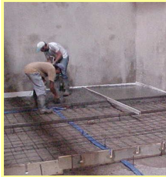
Fotografía N° 15: Ejecución de contrapisos de hormigón
