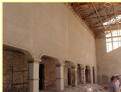
Fotografía N° 11: Ejecución de revoque en paredes
