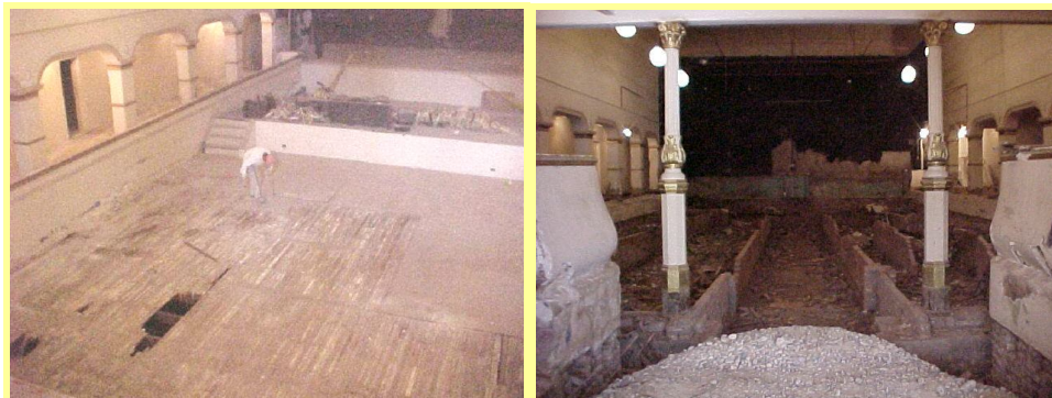
Fotografía N° 1 y 2: Estado del piso en salón .y tareas de desmote
