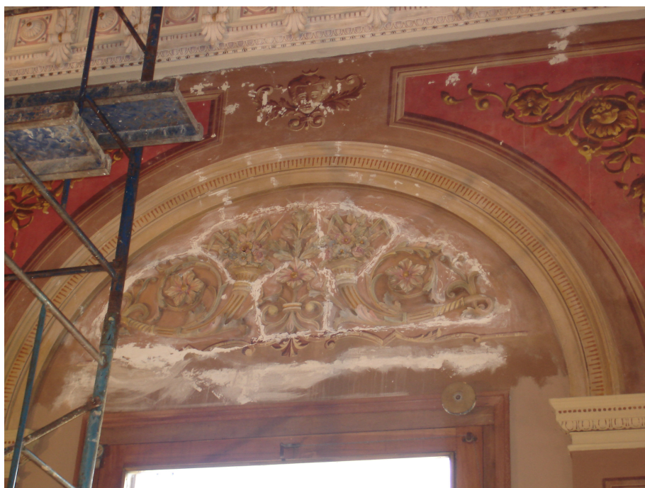
Consolidación y estucado de grietas en bajo relieves
