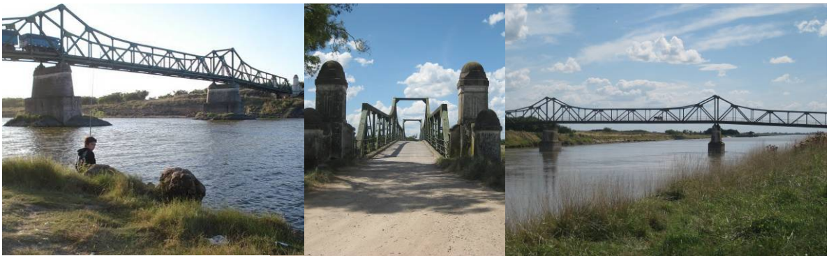
Figura 8: Puente de Pascua. Fotos del autor (2013).
