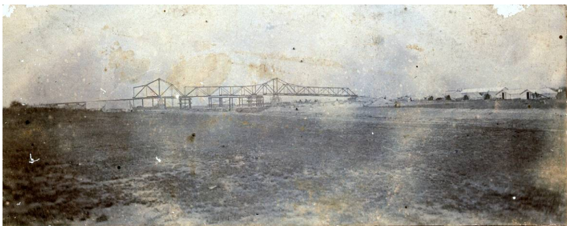
Figura 10: Puente Km. 335.00 en construcción. Fuente: fotos Sr. M. Cespedes (1910).
