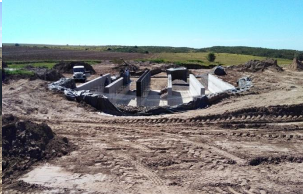
Figura 6. Construcción de puente realizada por Validad Provincial.
