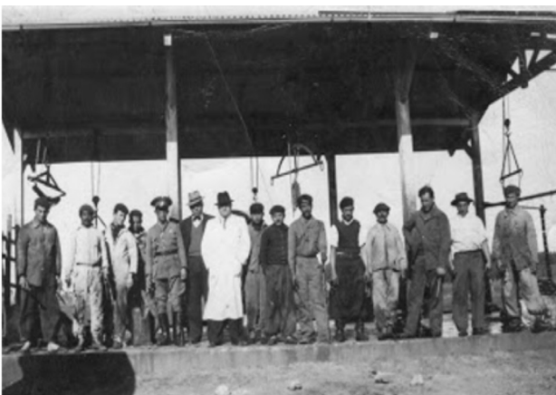
Matadero. Localidad de Tapalqué. 1930.
