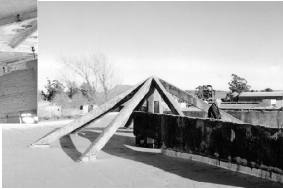
Detalle de la terraza del Matadero Municipal de Balcarce.
