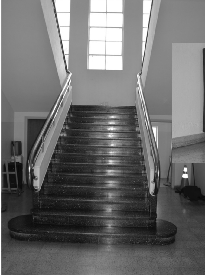
Escalera. Municipalidad de Pellegrini.
