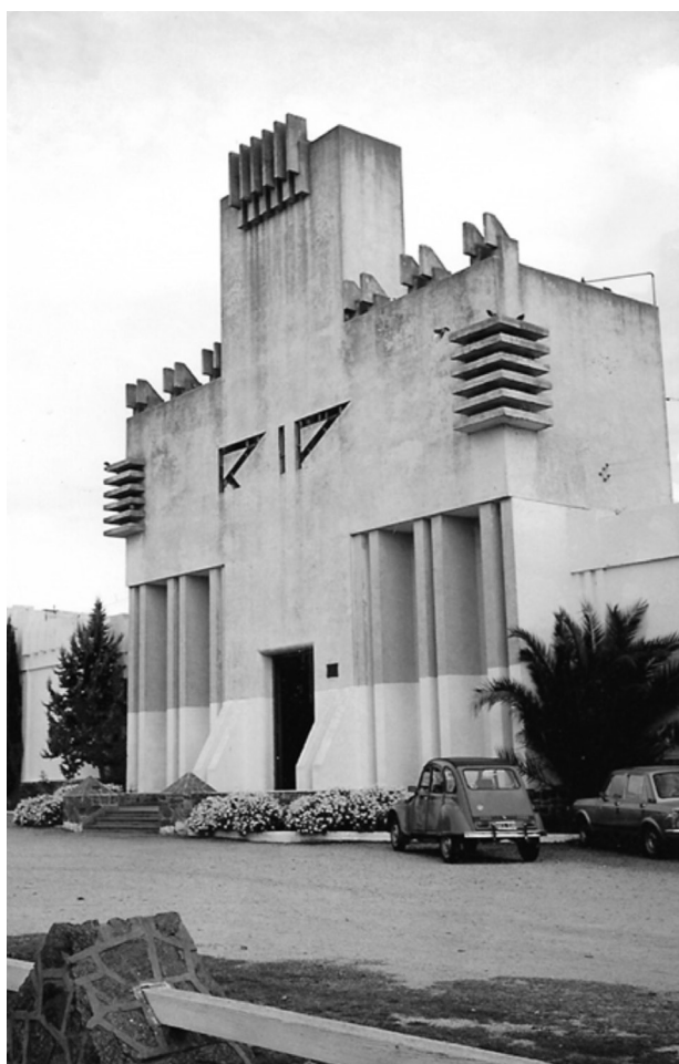
Portal del Cementerio de Balcarce.
