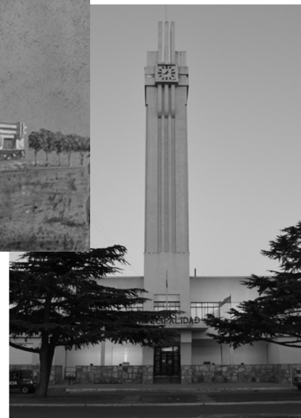
Palacio Municipal de Tornquist. Acuarela del Ing. Arq. F. Salamone y edificación.
