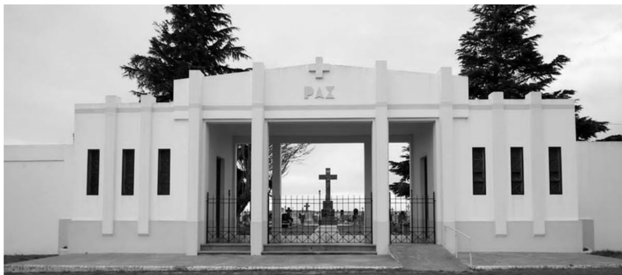
Vista general del Portal del Cementerio de Arroyo Corto. Se observa el Cristo Crucificado.
