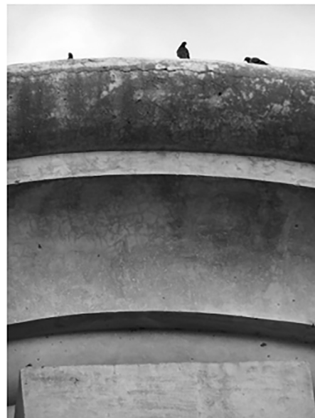
Detalle del borde colonizado del círculo del Portal del Cementerio de Saldungaray.
