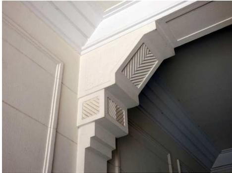
Figura 23: detalle encuentro viga- columna
