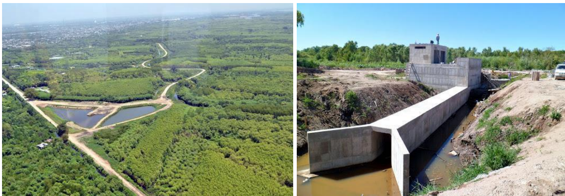
Figura N° 3: Terraplén y obras paralelas (compuertas y estación de bombeo).
